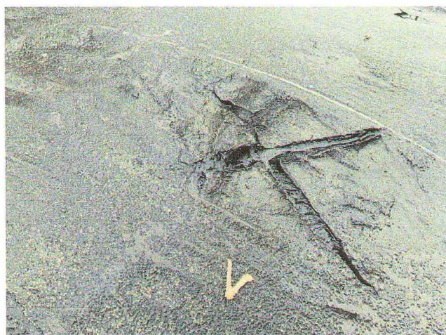
Фото №18. Трещины, пробои.
