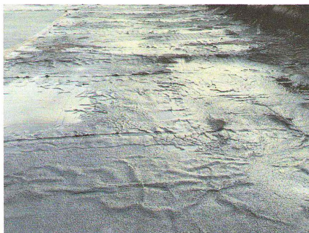
Фото №18. Трещины, пробои.
