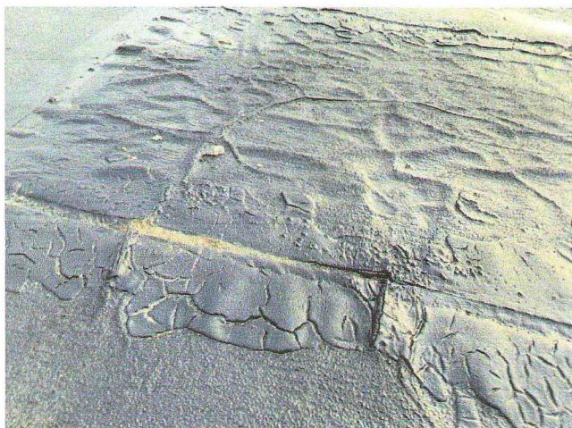
Фото №18. Трещины, пробои.
