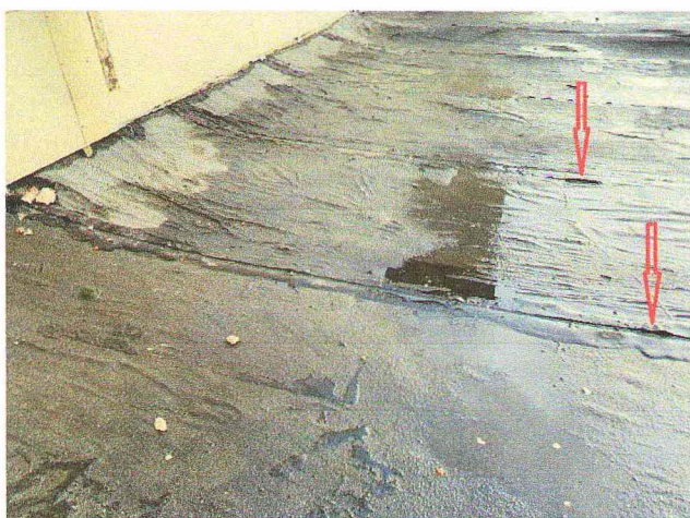
Фото №18. Трещины, пробои.
