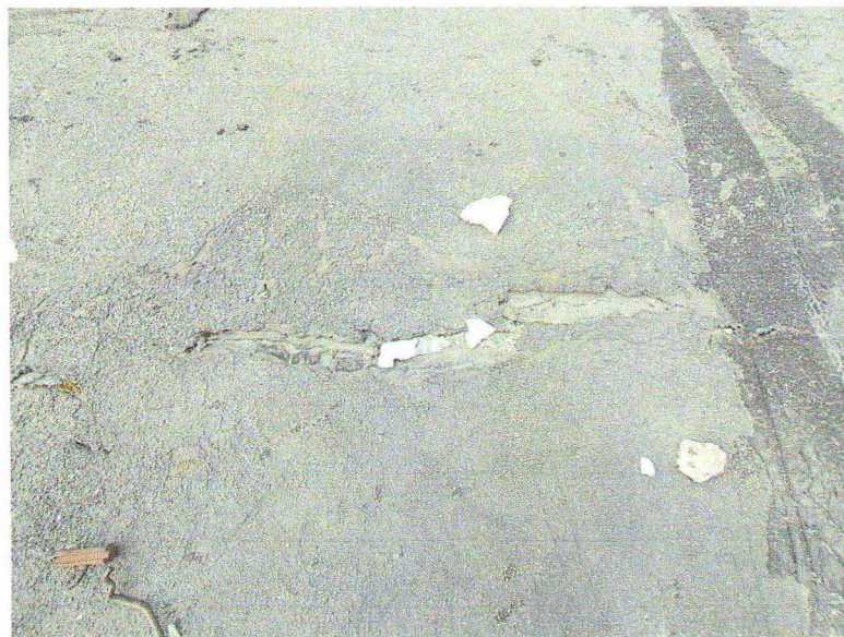
Фото №17. Разрывы покрытия.
