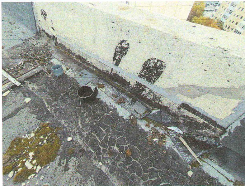
Фото №17. Разрывы покрытия.
