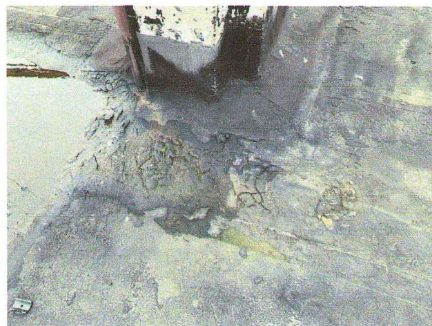
Фото №18. Трещины, пробои.
