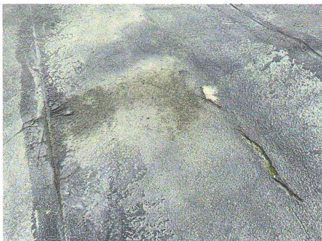
Фото №18. Трещины, пробои.
