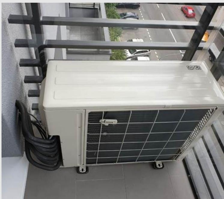
Рис. 1 «Наружный блок на вибропроставках, до монтажа корзины»
