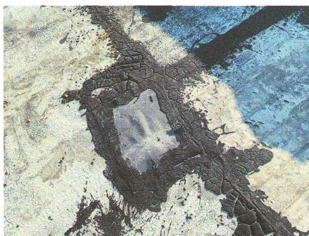
Фото №18. Трещины, пробои.
