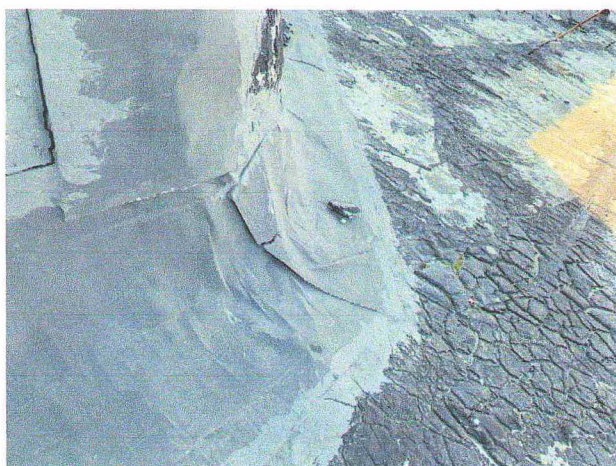
Фото №18. Трещины, пробои.
